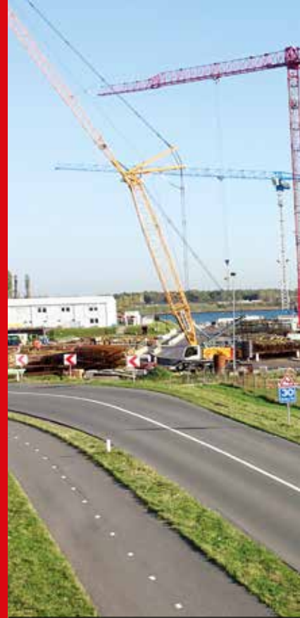
De aanleg van de Blankenburgverbinding za
