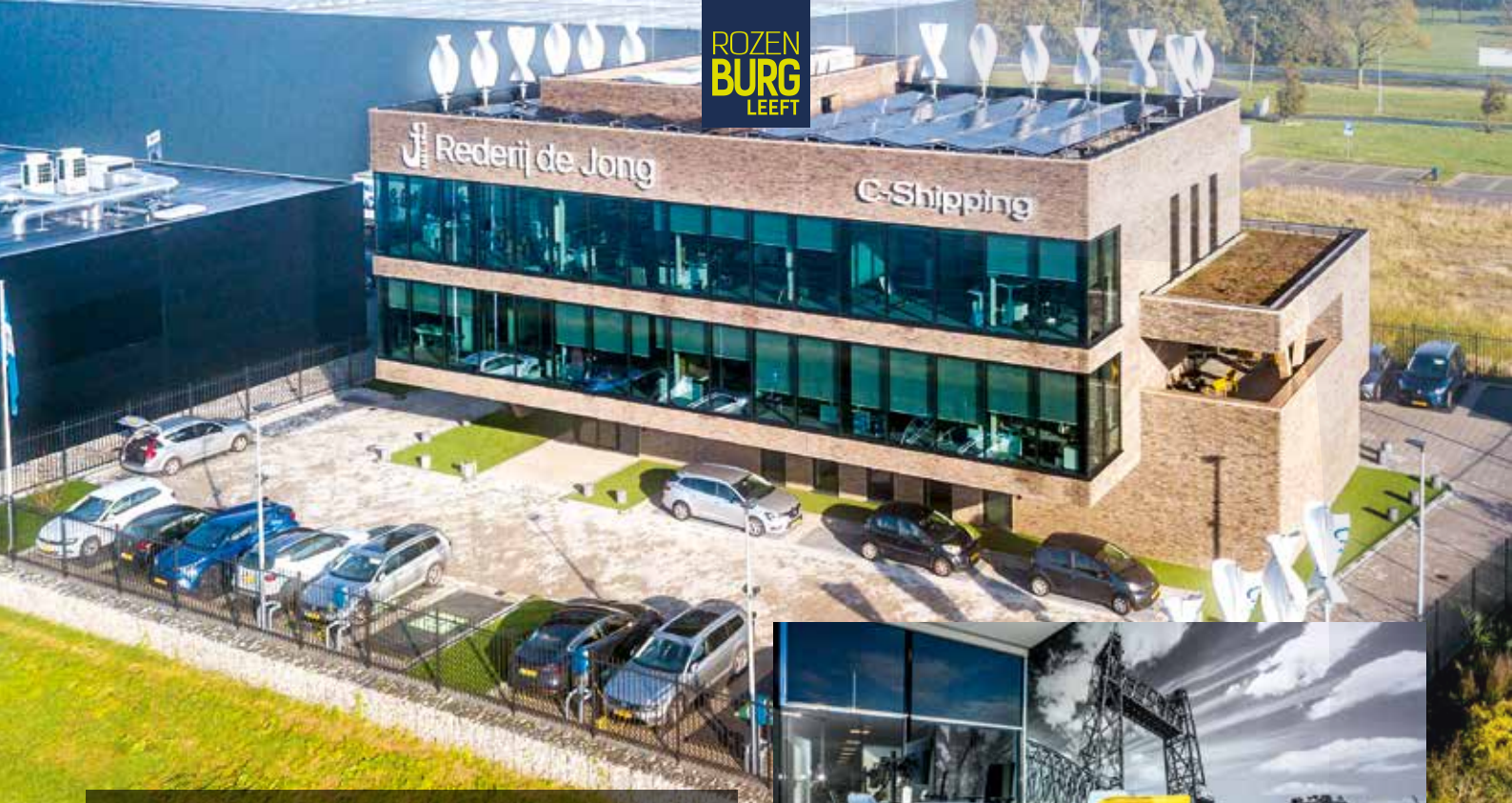
Op het dak en naast het kantoor staan windwakkels die energie opwekken voor de elektrische auto's. Foto's: Patrick Wanders
